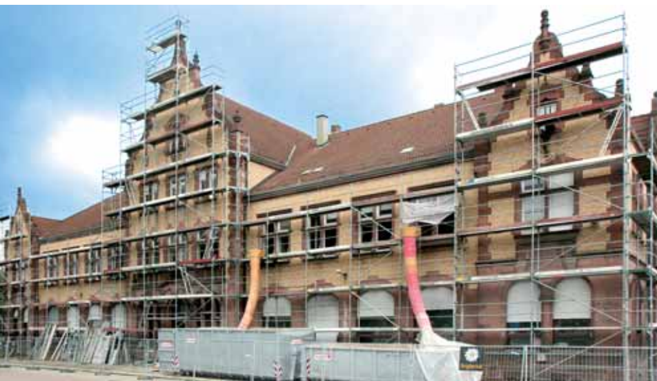
Sie bildet den Auftakt für die Entwicklung des Güterbahnhofs: Die alte Zollhalle von 1903 wird derzeit für zehn Millionen Euro umgebaut. Foto: © Matthias Koch
