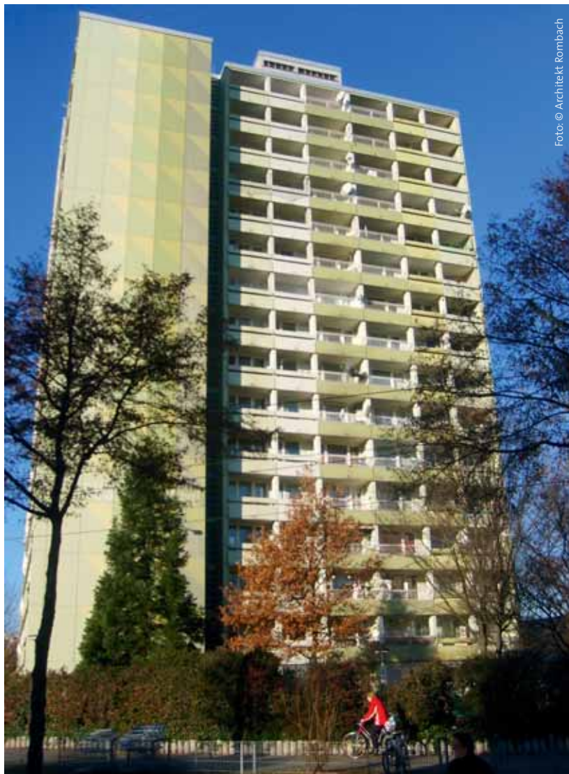
Eine Energieschleuder , die zum Passivhaus umgebaut wird: Das Haus in der Bugginger Straße 50 wird nach der Sanierung nur noch rund ein Viertel der derzeit jährlich 545.000 Kilowattstunden Heizenergie benötigen.
