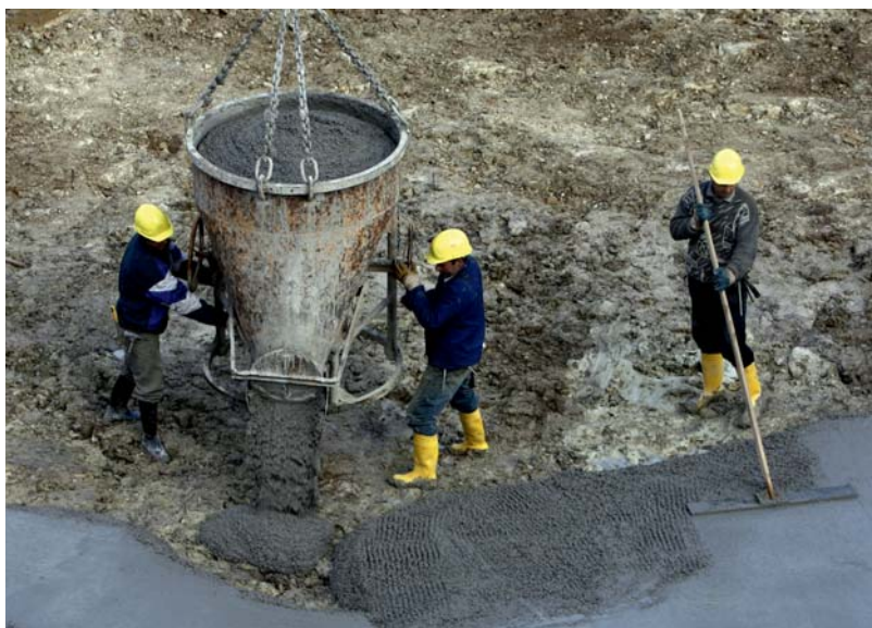
Kostbares Gut: Ohne Beton geht am Bau nichts. Weil der im Raum Südbaden offenbar besonders teuer ist, wäre ein Neubau wie das Quartier Unterlinden am Fahnenbergplatz in Stuttgart bis zu zwei Millionen Euro günstiger zu bauen. Foto: © ddp
